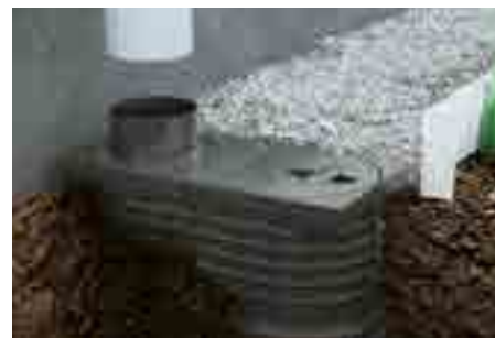
3. Priključiti vertikalno meteorono cev
