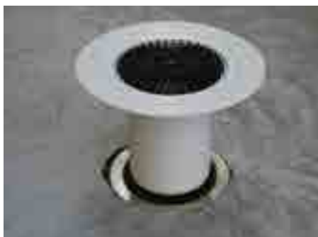
7. Cevni podaljšek HL350.0 namestiti na obroč za odvodnjavanje HL160
