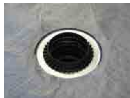
6. Sneti gradbeno zaščito, položiti ločilni sloj, vstaviti obroč za odvodnjavanje HL160
