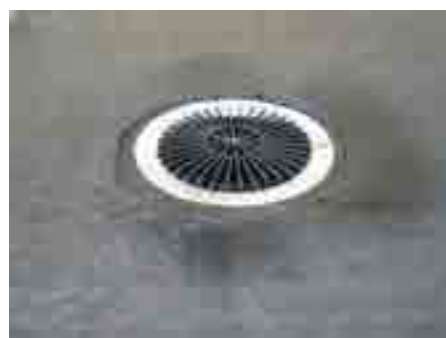
5. Strokovna vključitev odtoka v dvoslojno bitumensko izolacijo
