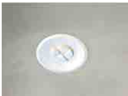
2. Pustiti, da estrih otrdi 3. Odstraniti gradbeno zaščito in očistiti tesnilno prirobnico, vložiti tesnilni obroč v utor tesnilne prirobnice
