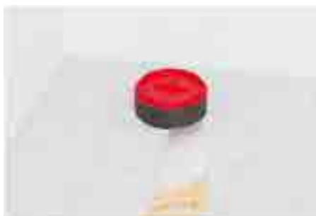
8. Ko se estrih strdi, zunaj štrleči del cevi odrežite z žago ravno z estrihom.
