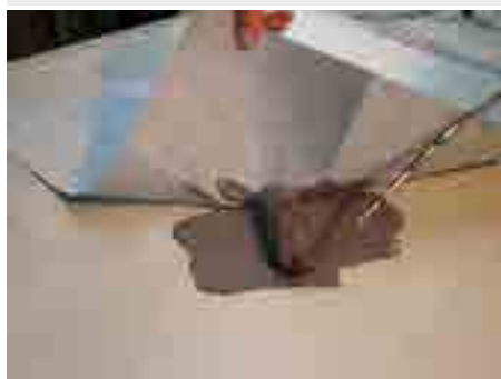
7. Hidroizolacijski premaz nanesti pod folijo po celi površini
