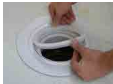
9. Prozoren plastični obroč namestiti v predviden krožni utor tesnilne prirobnice.
